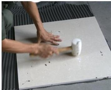
图 3.7.2 橡皮锤辅助施工
