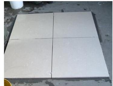
图 3.7.3 面材留缝
