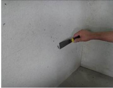
图 3.1.1 使用灰油铲去除基面污渍
