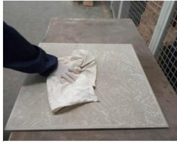
图 3.2.1 面材粘贴面清理
